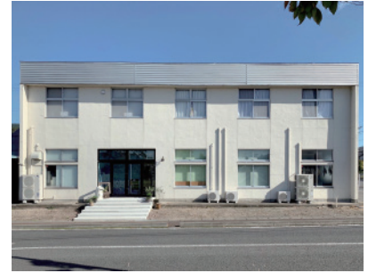
改修後の「アカリ」外観。公民連携は町にとって初経験なので、責任区分を明確にすると共に、町発注の工事（A 工事）の設計・工事監理には case-by-case が関わった。
